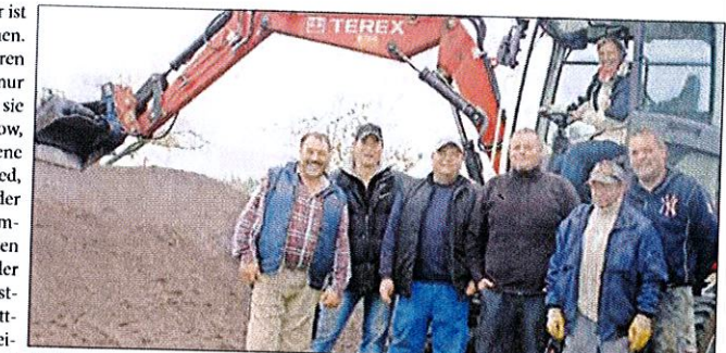
Nach getaner Arbeit freuen sich Karin Wiserner (hinten) und die zahlreichen Helfer von HPG, StraLaBau und Frey über den neuen Berg. Fotos (2): Sommerfeld
