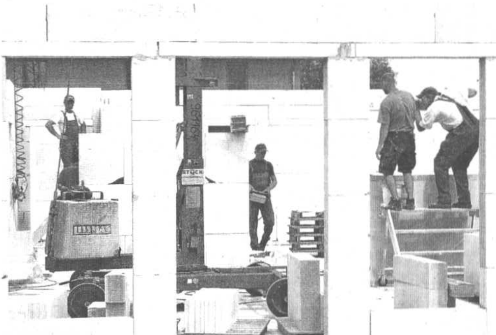
Von Wochenende keine Spur: Emsig wird in den Havelauen gebaut – wie hier an der neuen Kita.
