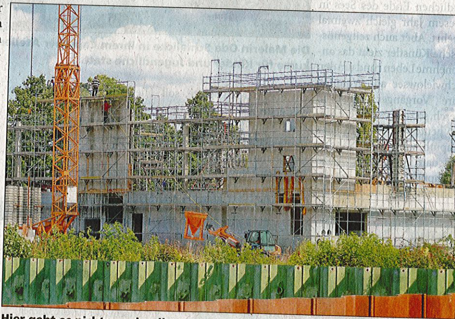
Hier geht es nicht so schnell voran wie auf der Promenade. Auf der Nordseite der Therme entsteht gerade der Anfang der ersten Etage.
